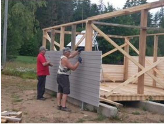
Puuvajan rakentaminen Orisuolla.
